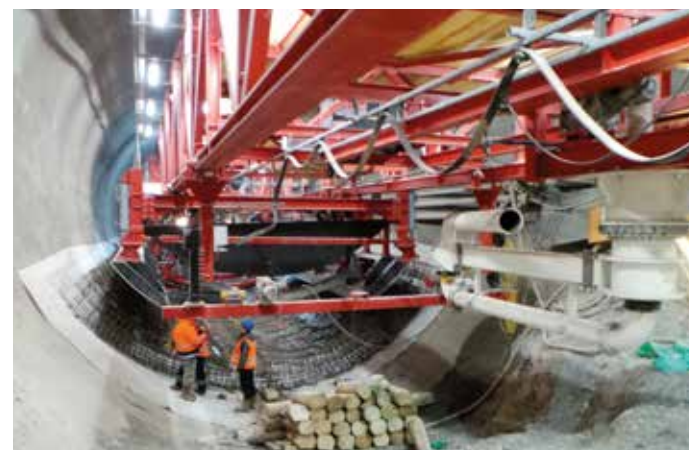
Sohlbewehrung und Sohlschalwagen im Streckentunnel Richtung Hauptbahnhof
