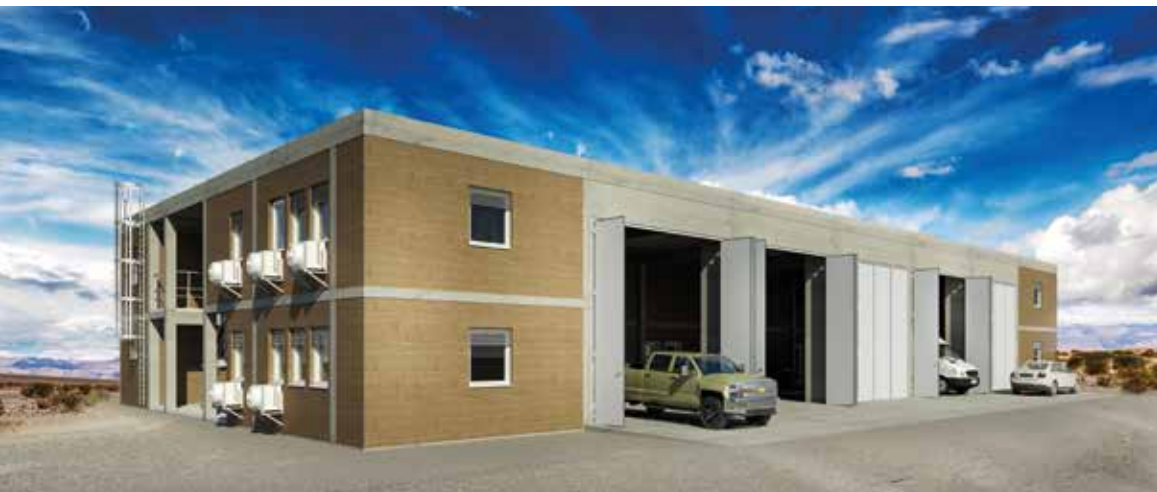
Werkstattgebäude Zementwerk in Ostafrika. ©Loesche GmbH
