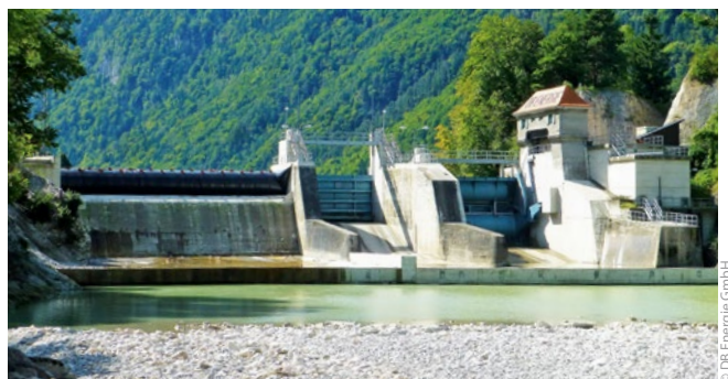
Bild 1: Absperrbauwerk Kibling nach der umfangreichen Sanierung
