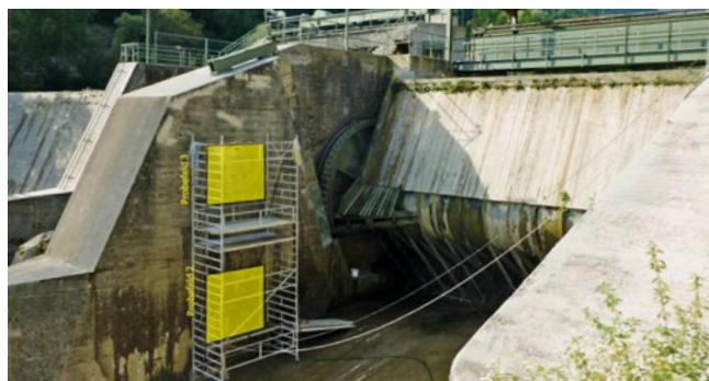
Bild 4: Lage der Probefelder (Probefeld 3 oben und Probefeld 2 unten) im Pfeiler
